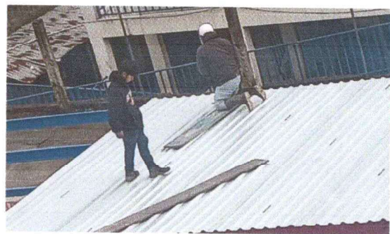
Foto 6: Colocación de lámina troquelada calibre 26 en el módulo 4.
