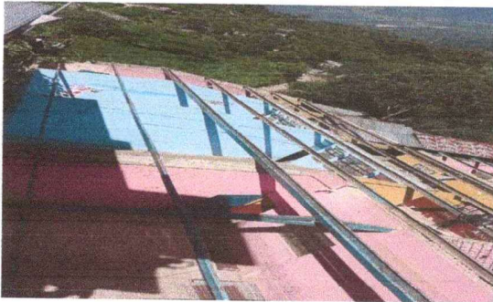
Foto 1: Trabajos de cubierta de lamina con la desmantelación de láminas de zinc oxidadas en el módulo 1.
